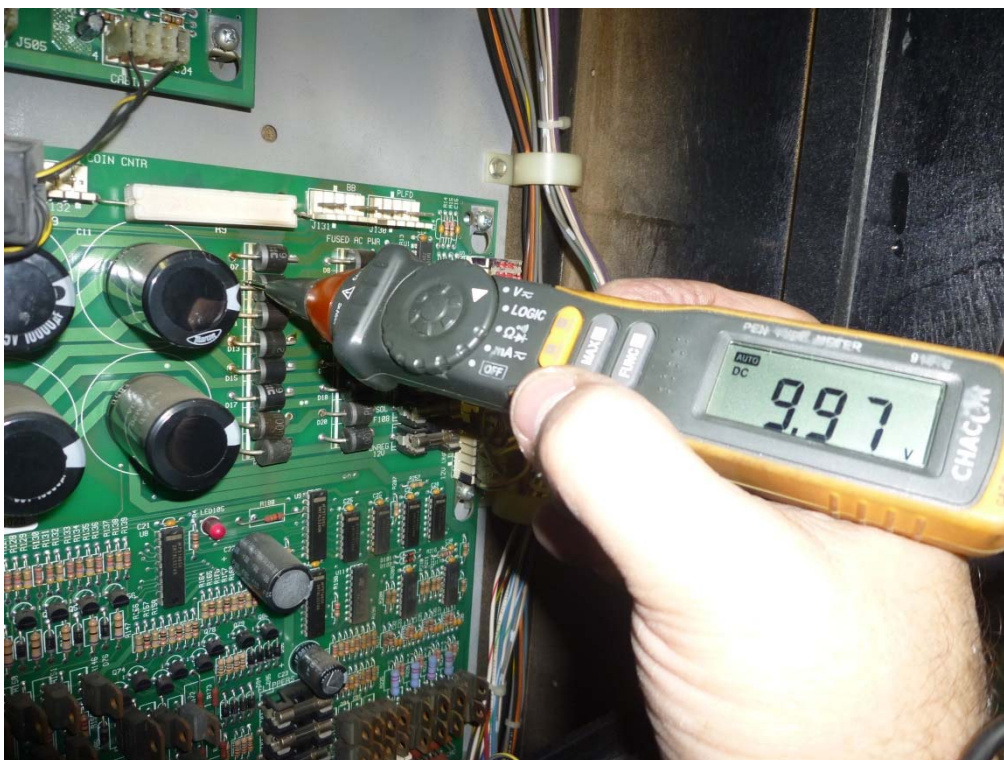
Mesure de la tension (9,97V DC) à la sortie du pont de diodes (sur les cartes WPC95, le pont de diodes est constitué de 4 diodes séparées D7 à D10). La mesure est faite sur la cathode (trait) de la diode D9 par rapport à la masse (une vis de fixation des cartes).
